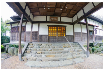
敷地内建物階段手すり
