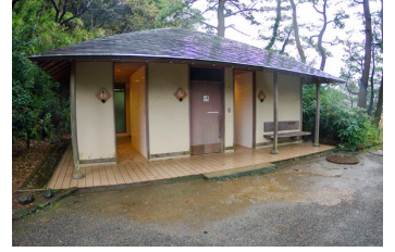
敷地内トイレ（外部）
