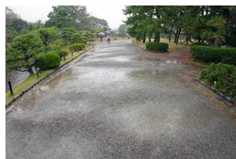
敷地内砂利面
