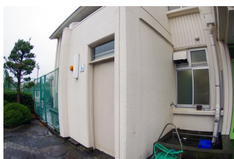
多機能トイレ (ドア)
