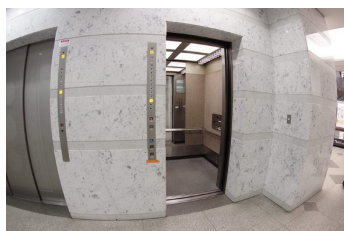
一般・車いす共用エレベーター
