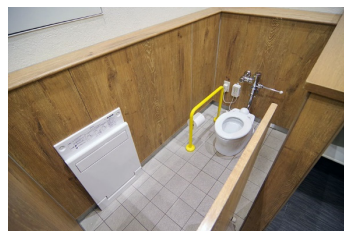
子ども用トイレ：3F中央エレベーター裏に、お子さま用のひとまわり小さなトイレがあります。 ※3Fキッズルーム「おやこの森」にもキッズトイレがあります。
