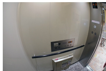
ボタン位置（一般・車いす共用エレベーター）
