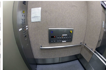
一般・車いす共用エレベーター（内部）
