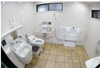
多機能トイレ（内部）
