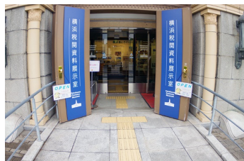
点字ブロック（エントランス）
