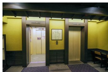
一般・車いす共用エレベーター
