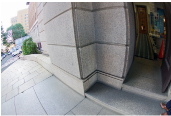
駐車場からエントランスまでのスロープ
