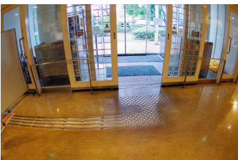
点字ブロック (エントランス)
